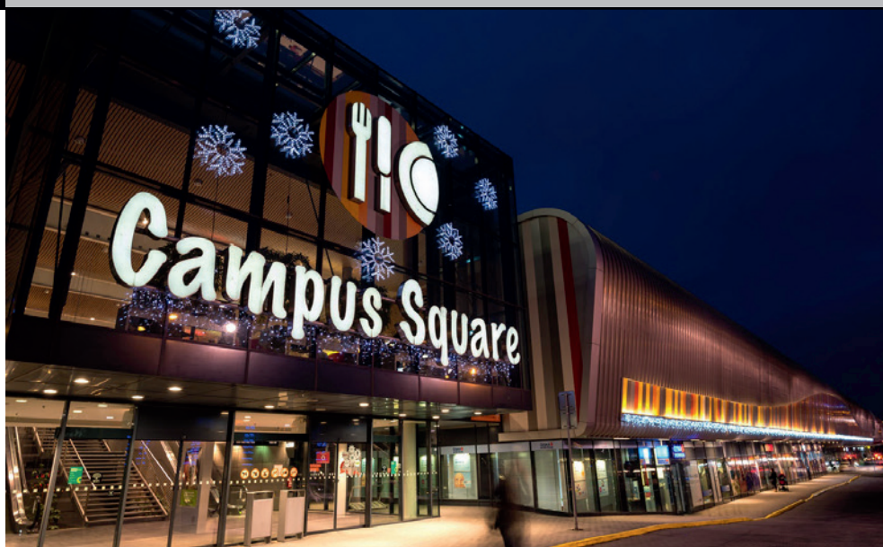
Letošní novinkou v portfoliu společnosti Rilancio je brněnské obchodní centrum Campus Square Technický facility management: Rilancio
