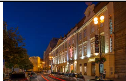
Slovanský dům, Praha 1 ■ Technický facility management: Rilancio ■ Portfolio ve správě Rilancia tvoří přes 1,2 milionu m² kancelářských a 490 000 m² maloobchodních prostor
