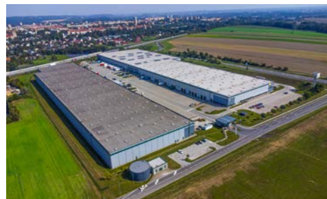
PEC Ostrava ■ Technický facility management: Rilancio Rilancio spravuje aktuálně více než 664 000 m² průmyslových a distribučních prostor
