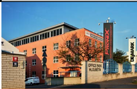
Office Park Hloubětín, Praha 9 • Technický FM: Rilancio
