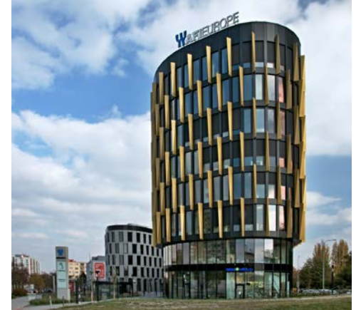
AFI Vokovice v Praze 6 – budova byla dokončena v létě 2018 Developer: AFI Europe ■ Technický FM: Rilancio
