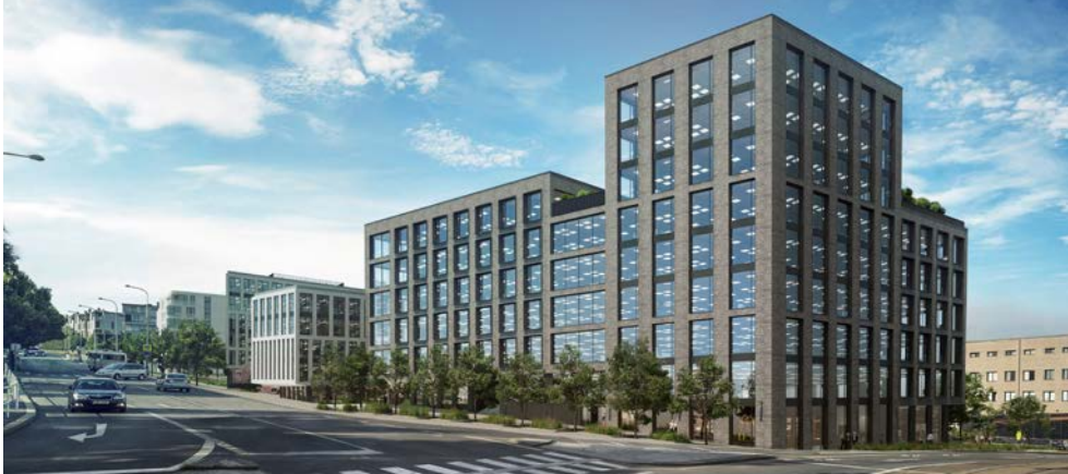
Kancelářský komplex Churchill vznikající v sousedství Hlavního nádraží v centru Prahy ■ Developer: Penta Technický FM: Rilancio
