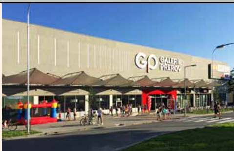
Galerie Přerov ■ Facility management: Rilancio
