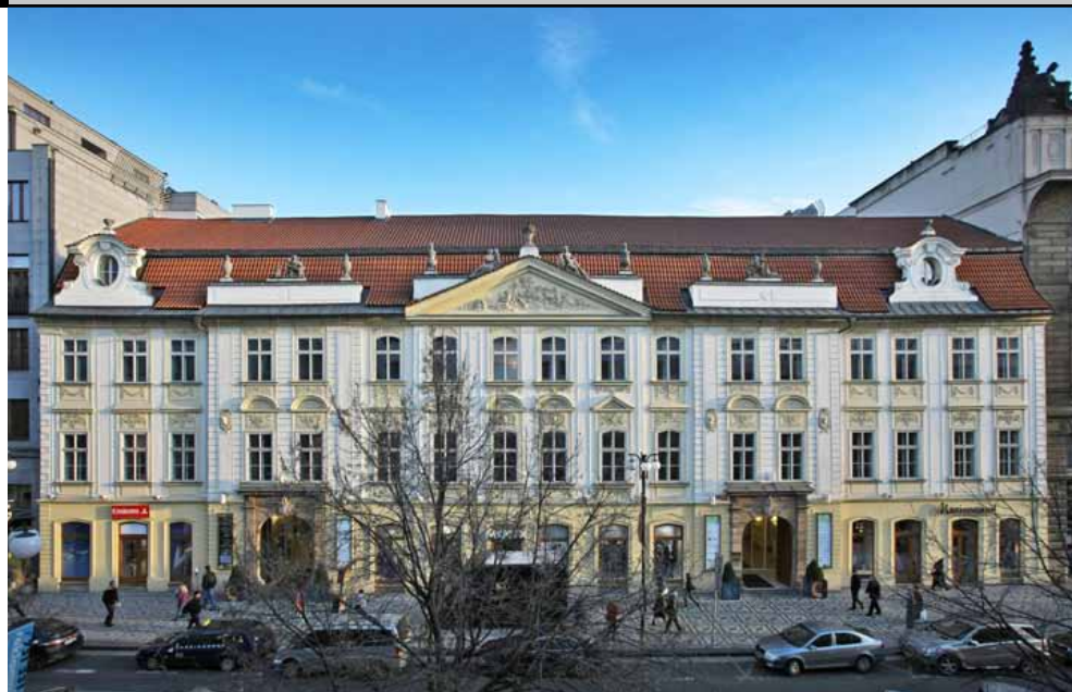
Slovanský dům na hlavní nákupní třídě Na Příkopě v Praze 1 ■ Facility management: Rilancio
